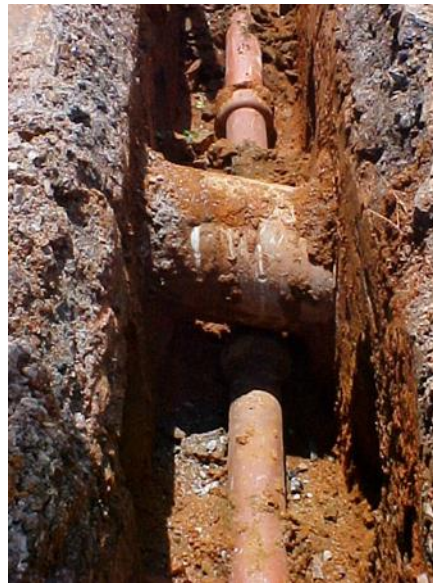
Rede Pluvial e de Esgotos
