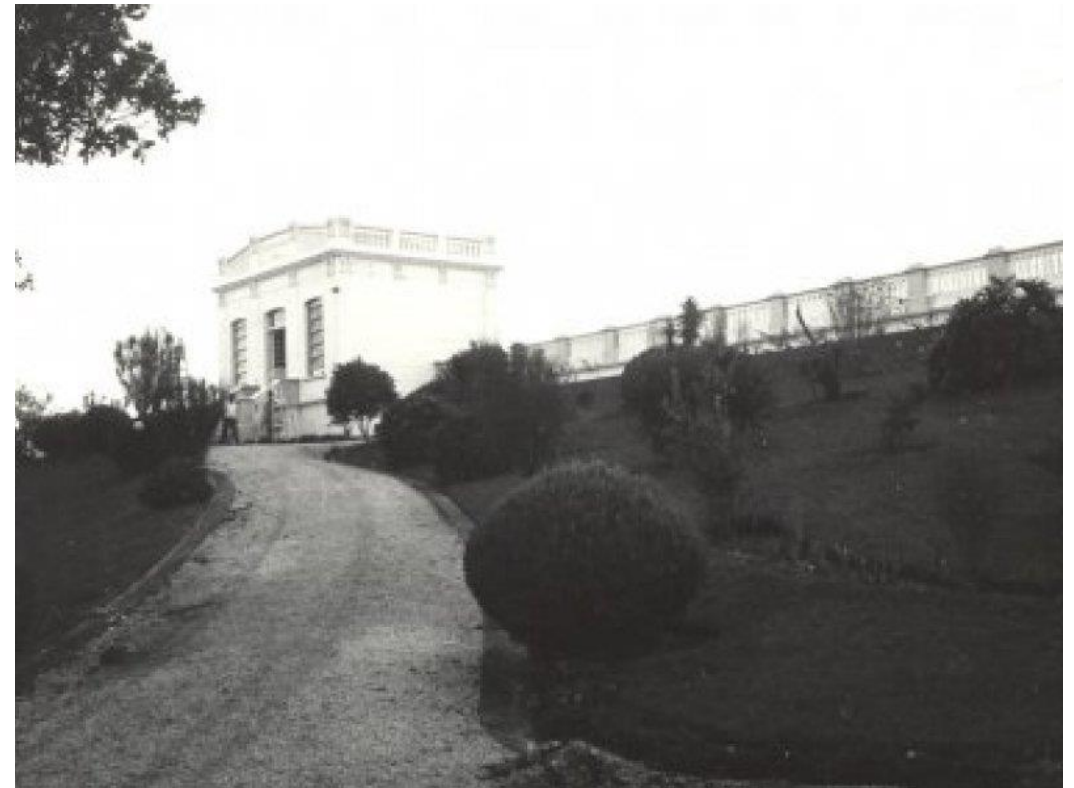
Reservatório Batel, inaugurado em 1928
