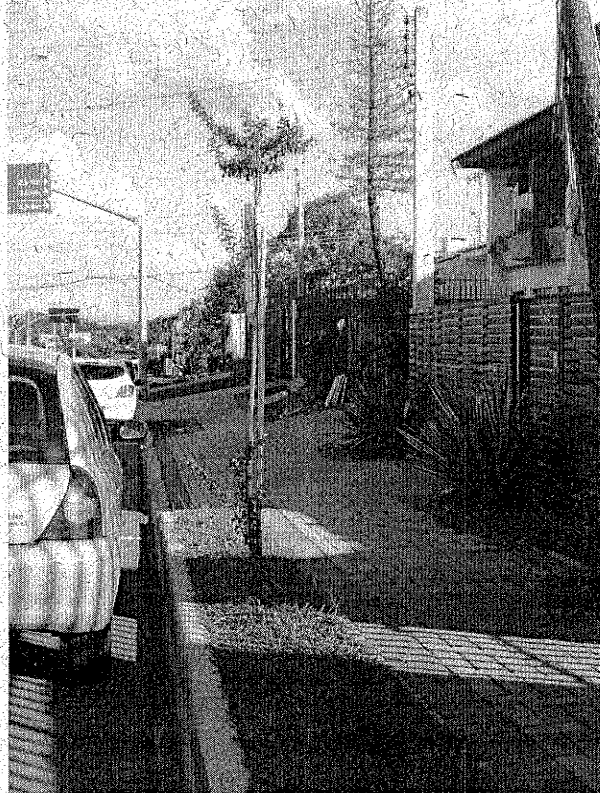
Imagem 01: trecho de calçada com inclinação transversal superior a 03%.
